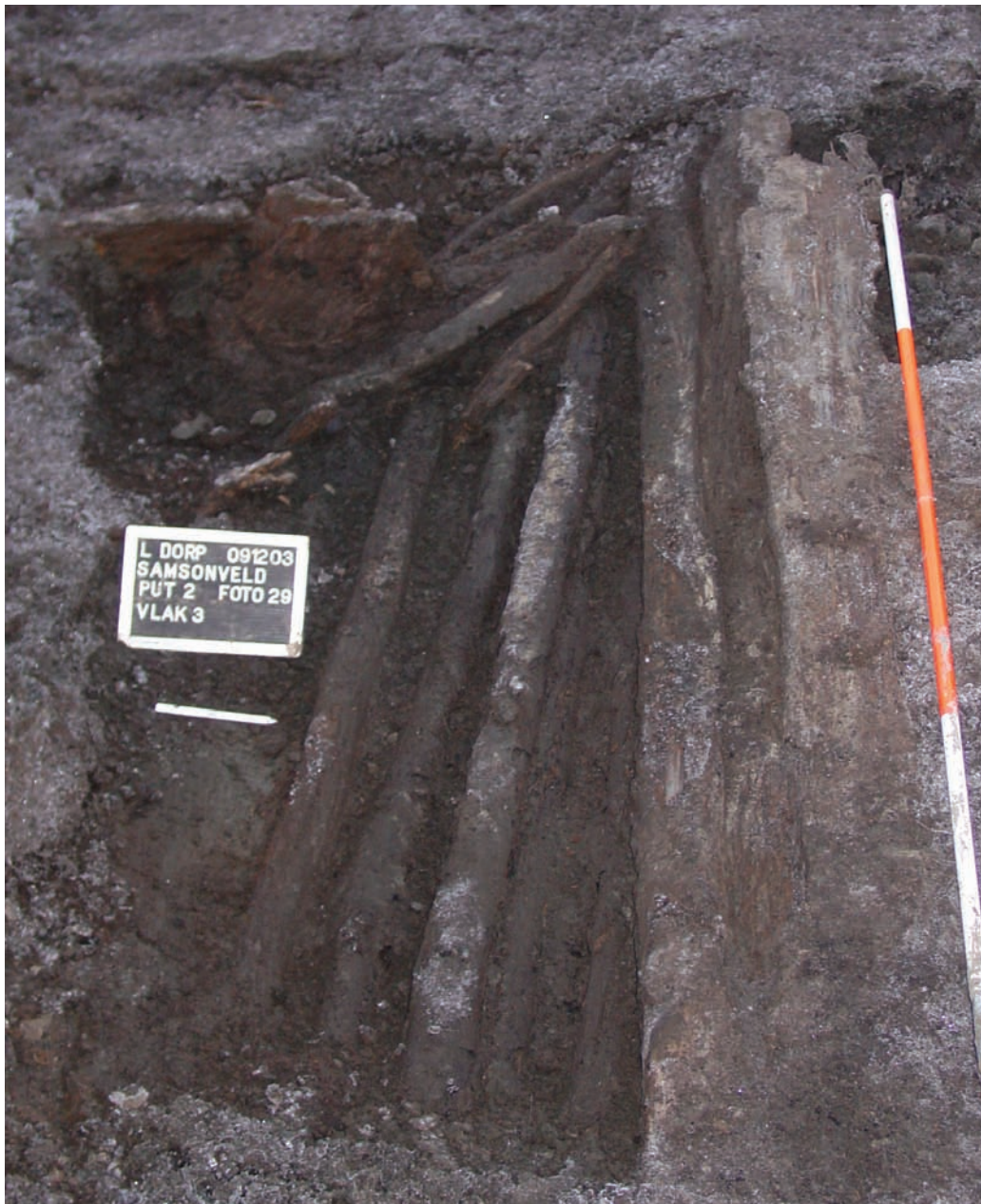
Afbeelding 24. a. Deze bladzijde beschoeiingsvak van liggende stammen op het Samsonveld. b. Andere bladzijde overzicht van de beschoeiingen. Bij iedere witte prikker is een houten staander aangetroffen waartussen liggende stammen zijn bevestigd. We zien hier een vlak vol met beschoeiingswerken. Dergelijke infrastructurele ingrepen uit de vroege middeleeuwen zijn typerend voor de vindplaatsen in Leidendorp. Ook aan de Simon Smitweg en Parallelweg zijn beschoeiingselementen teruggevonden uit zowel de Romeinse tijd als de vroege middeleeuwen.
